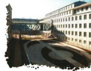
Spazierhöfe zwischen Altbäude (links) und Neubau mit der großen Verbindungsbrücke
